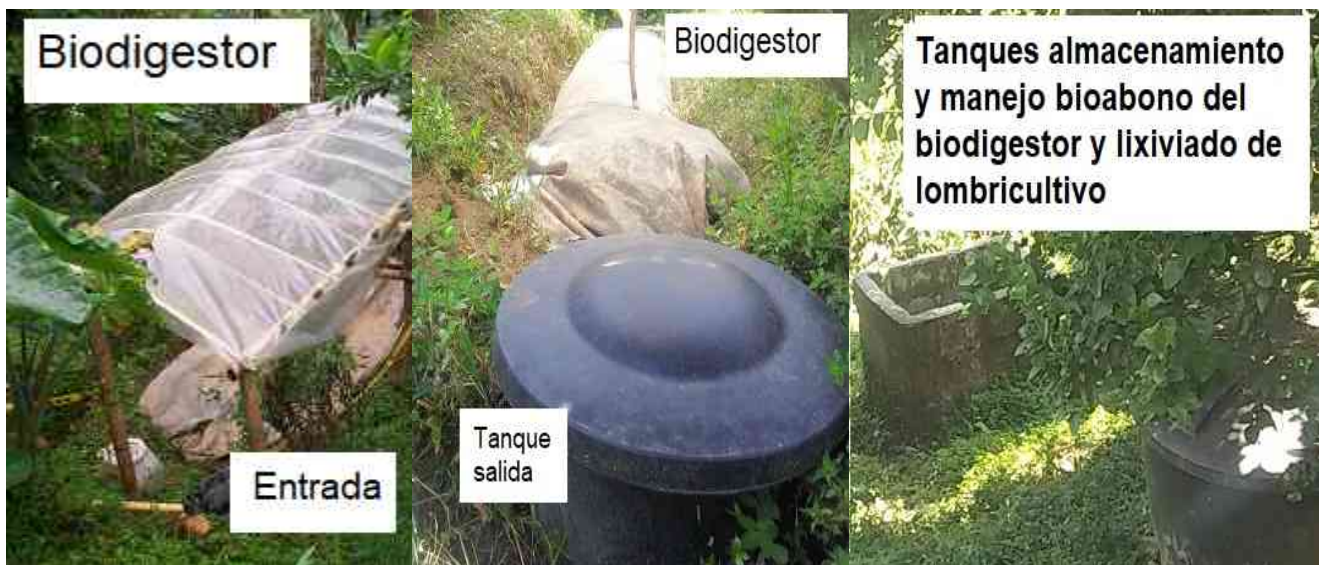
Biodigestor y tanques de manejo de los bioabonos líquidos
